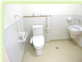
多目的トイレ
